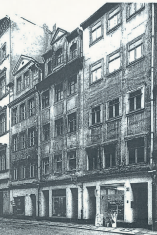
Barfußgässchen Nr. 3, 5 und 7, Zustand vor der Sanierung, Blick nach Südosten
