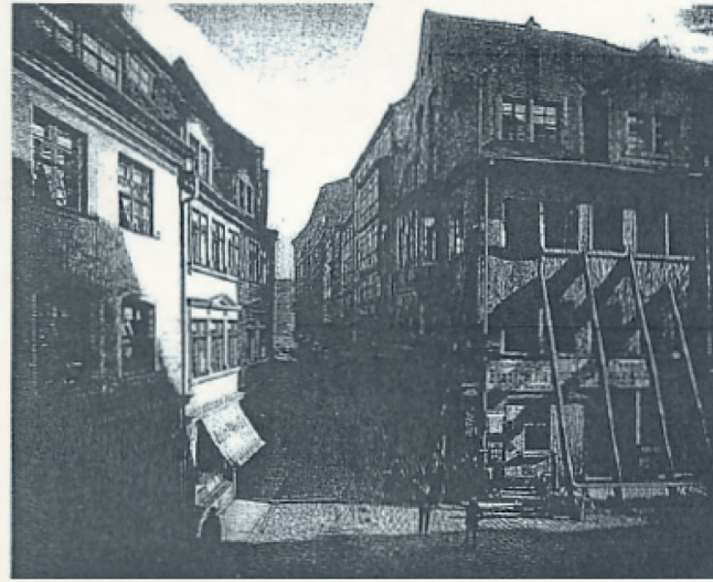
Barfußgässchen nach Osten mit altem „Zills Tunnel“ vor dem Abbruch 1887, Foto von Hermann Walther
